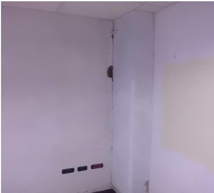
4) Particolare dell'intervento di pretrattamento
