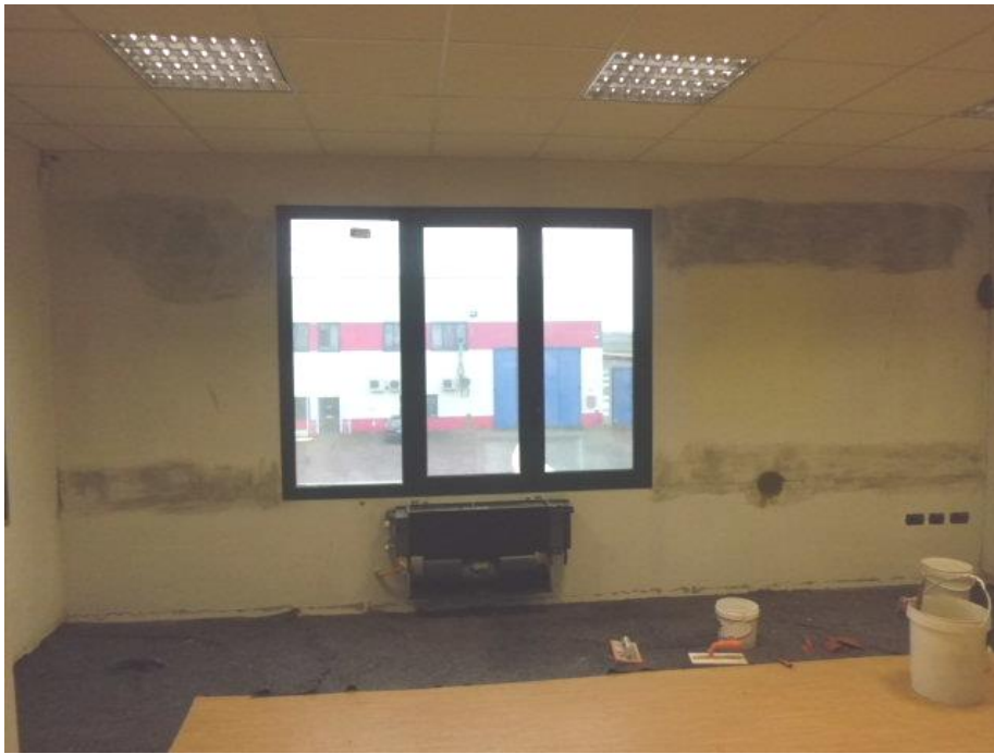
7) superficie preparata al trattamento di coibentazione
