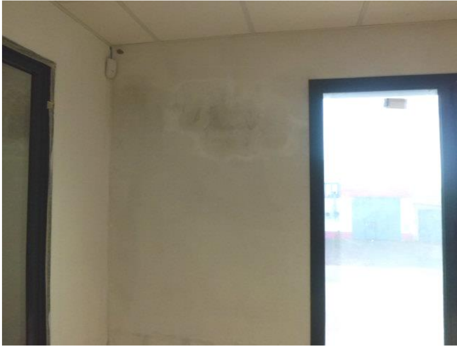
5) pretrattamento di porzioni di superficie interessate da fenomeni di muffa e sollevamento del rivestimento murale preesistente per effetto dell'accumulo di condensa verso l'alto.
