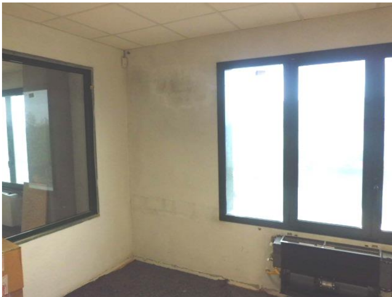
2) Fase di pretrattamento particolare di ponti termici
