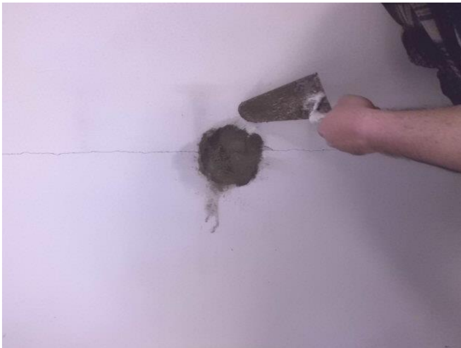
6) intervento di ripristino della struttura murale attraverso stuccatura di sezioni verticali ed orizzontali lese
