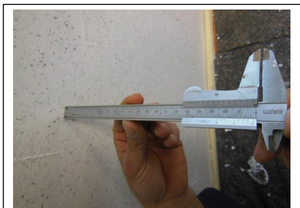
13) misurazione calibrata dello spessore applicato
