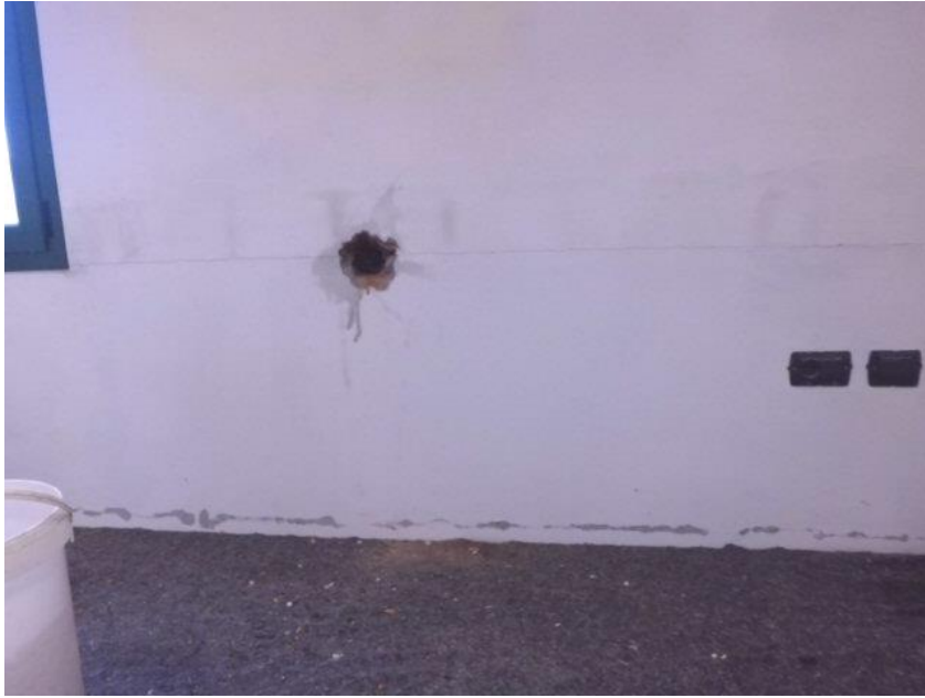
3) Particolare dell'intervento di pretrattamento
