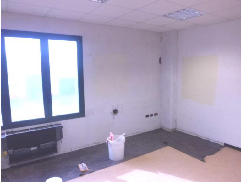
1) Fase di pretrattamento di involucro abitativo interno in struttura multipla con infissi-termoventilatori- colonne rivestite in cartongesso- solaio a pannellatura- pavimentazione in legno
