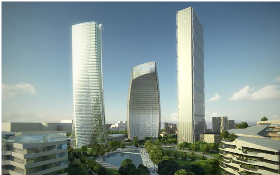
Fig.17: Tipologia 4: involucri abitativi giacenti in edifici con strutture esterne non murarie
